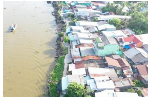
Hình 2. Hiện trạng sạt lở tuyến sông Chà Và
