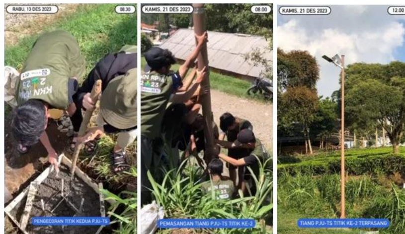
Gambar 6. Proses pemasangan lampu PJUTS
