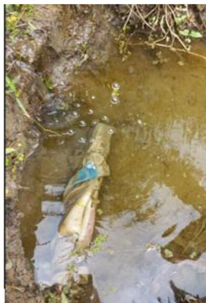
**Gambar 8.** Saringan Sederhana pada Pipa di Sumber Mata Air
