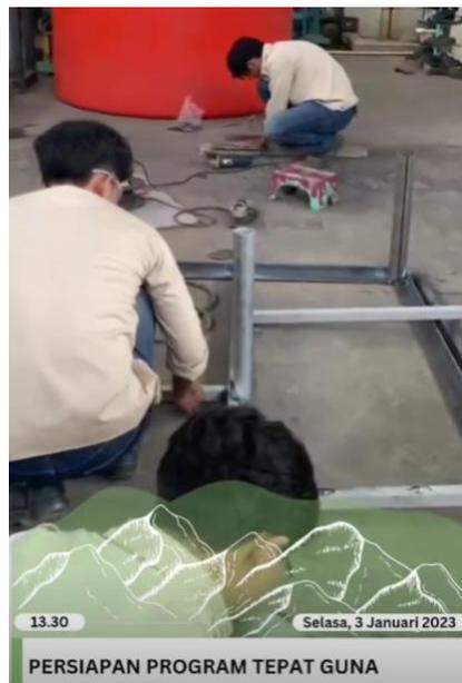
**Gambar 7.** Proses Fabrikasi Rangka Tangki Air
