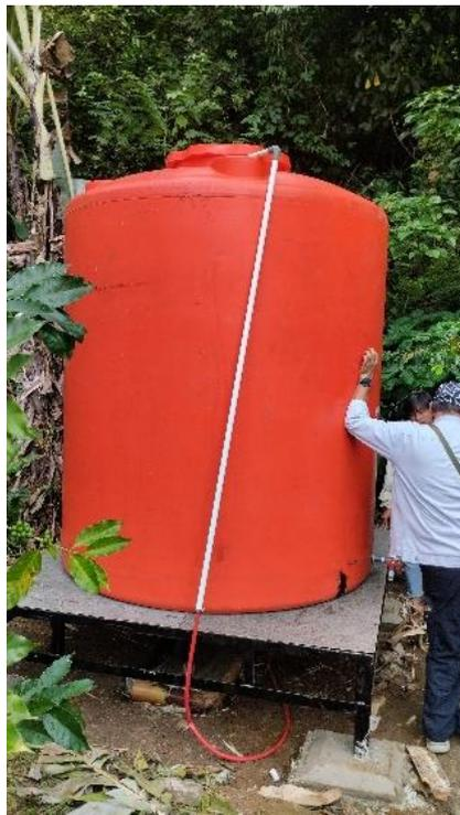
**Gambar 10.** Tangki Penampungan Air Beserta Sistem Rangka yang Telah Terpasang
