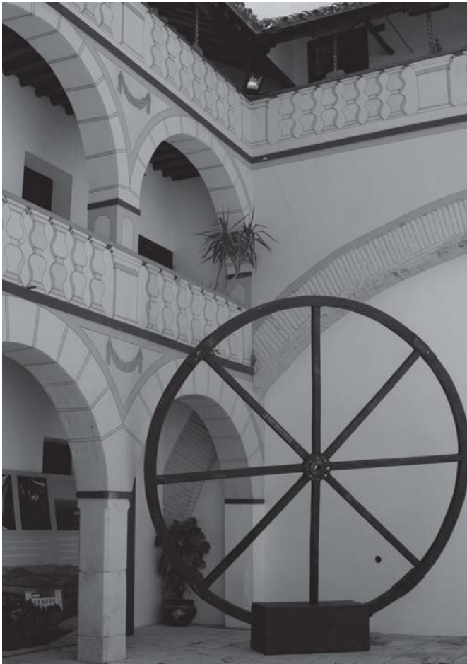
Fig. 5. Muro sur del patio.
