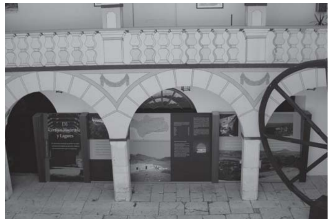
Fig. 4. Arquería baja del patio.
