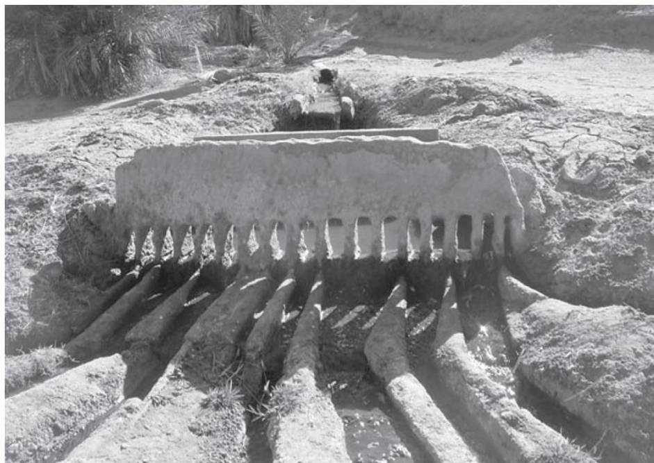
Figura 3. Qasri situado a la salida de una foggara (Fuente: Moussaoui, 2011).
