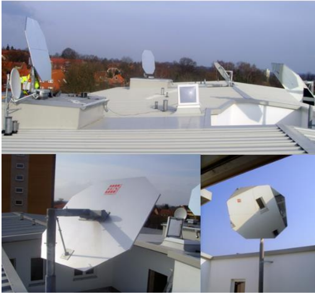
Fig. 17 Aporte de luz natural a un patio de luz mediante heliostatos y del reflector de desviación fijo.
