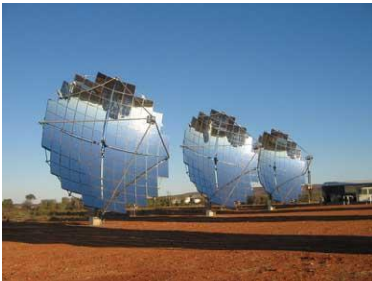
Fig. 55 Colector Multifaceta Planta demo en Solúcar, Sevilla
