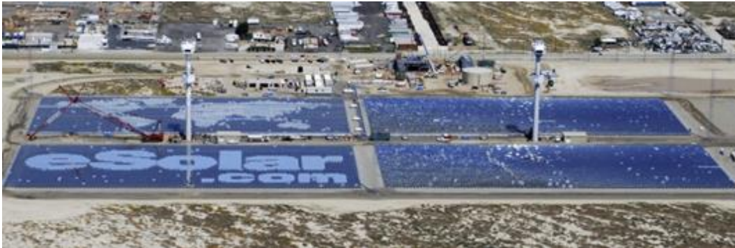
Fig. 16 Sierra Suntower instalación de demostración, Lancaster, CA, EE.UU.. Imagen de 2009.
