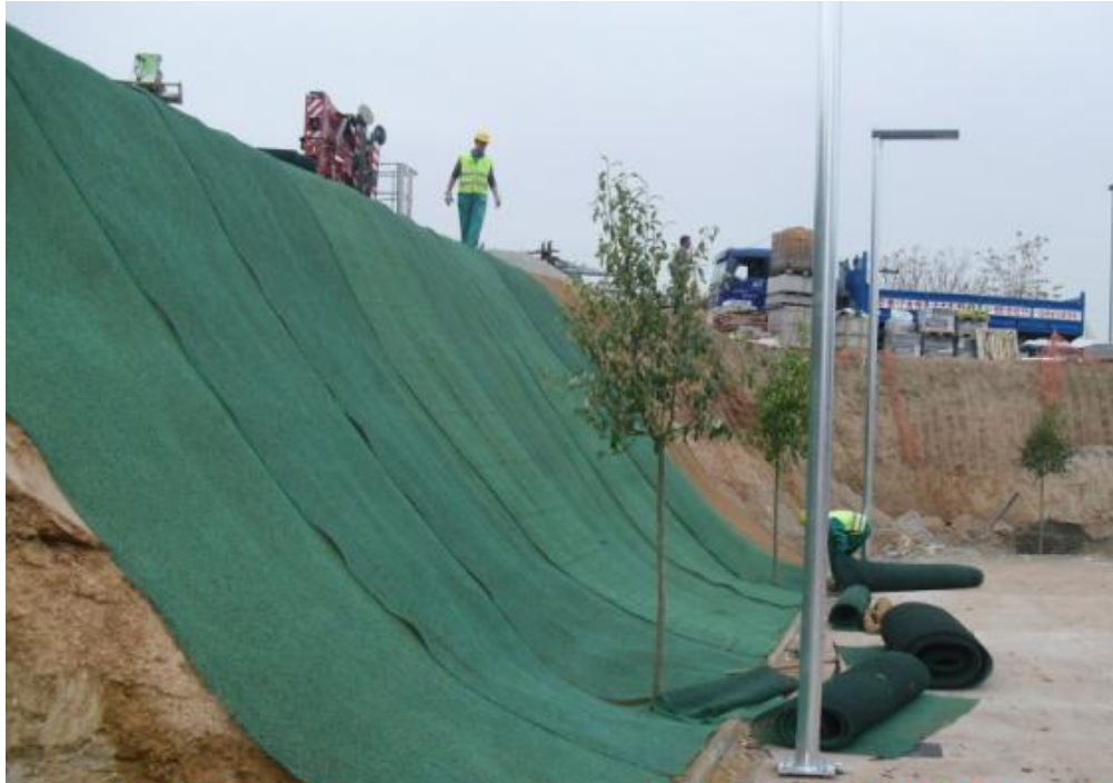
Figura 7. Instalación de una malla volumétrica.
