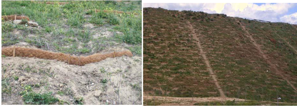
Figura 3. Detalle de fajinado con biorrollos en talud.
