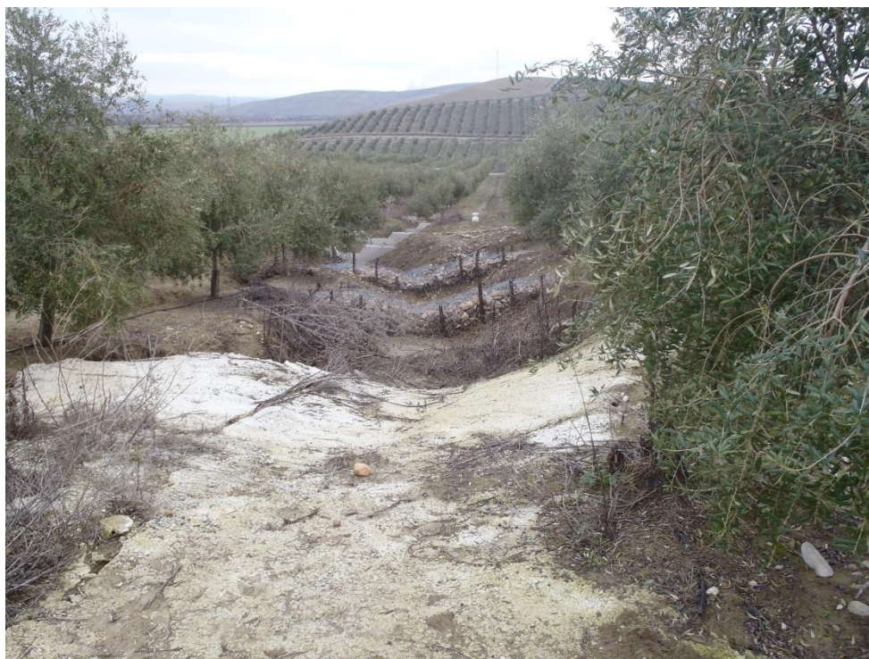
Figura 18. Ejemplos de diques de retención en cárcavas.
