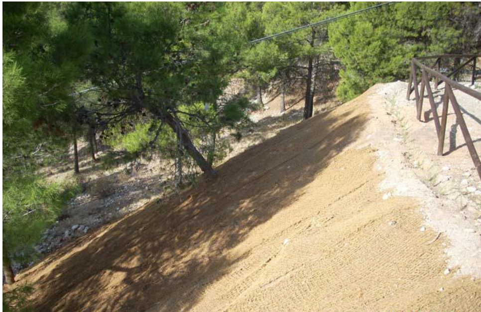
Figura 4. Instalación de una malla orgánica en un talud.
