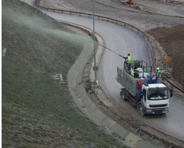
Figura 2. Aplicación de hidrosiembra sobre un desmonte.
