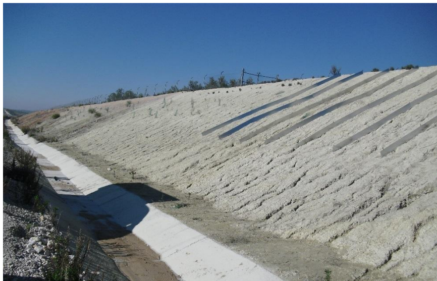
Figura 14. Desmorte tramo de infraestructura ferroviaria, Eje Marchena- Pedrera, (Osuna I)
