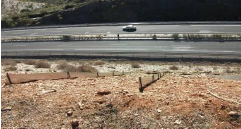
Figura 10. Vista del Desmorte de la A-92, en Fiñana, desde la coronación del talud.
