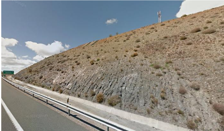
Figura 7. Desmonte A-92, Fiñana (Foto extraída de Google Maps®)
