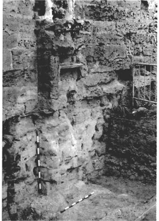
Foto 13. Jamba y arranque de arco del acceso al adarve documentado en corte 1
