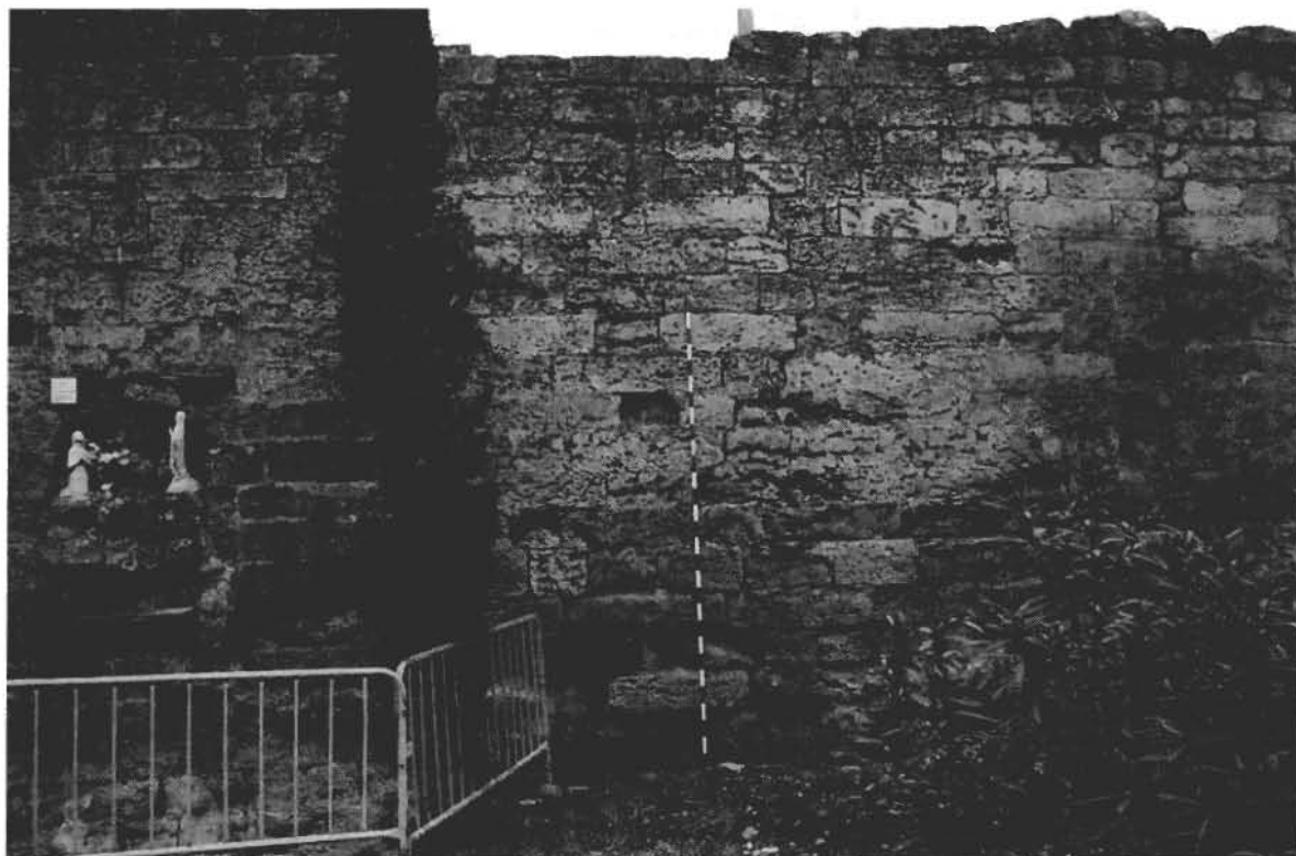
FOTO 14. Alzado de sillería correspondiente al muro conservado en el extremo septentrional de la Ronda del Marrubial.
