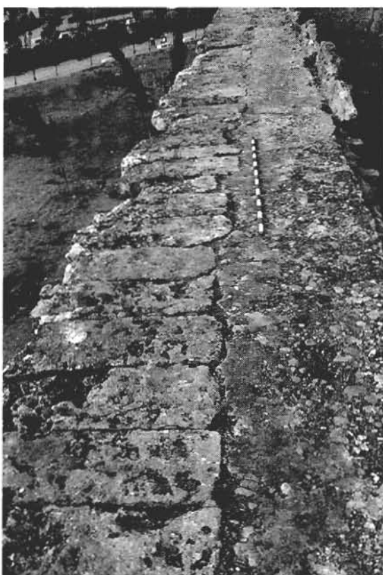
FOTO 9. Configuración del pavimento en el adarve
