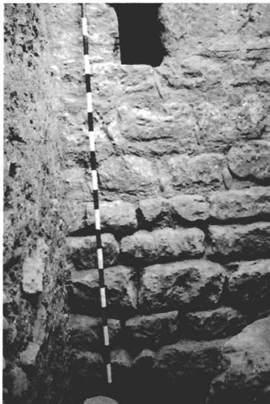
Foto 3. Sillarejos de cimentación de la muralla cristiana a intramuros, documentados en el corte 2
