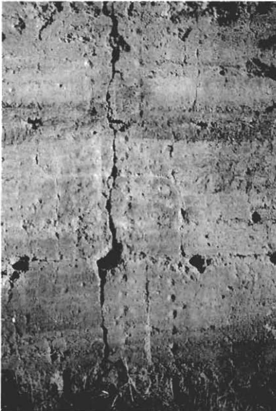
FOTO 7. Marcas de clavos sobre el enlucido de los lienzos de tapial a intramuros
