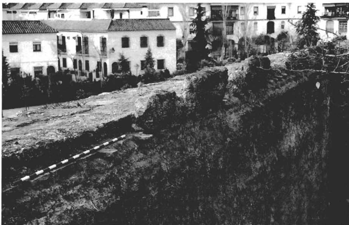
Foto 10. Vista del antepecho del adarve desde la cámara de la torre 2
