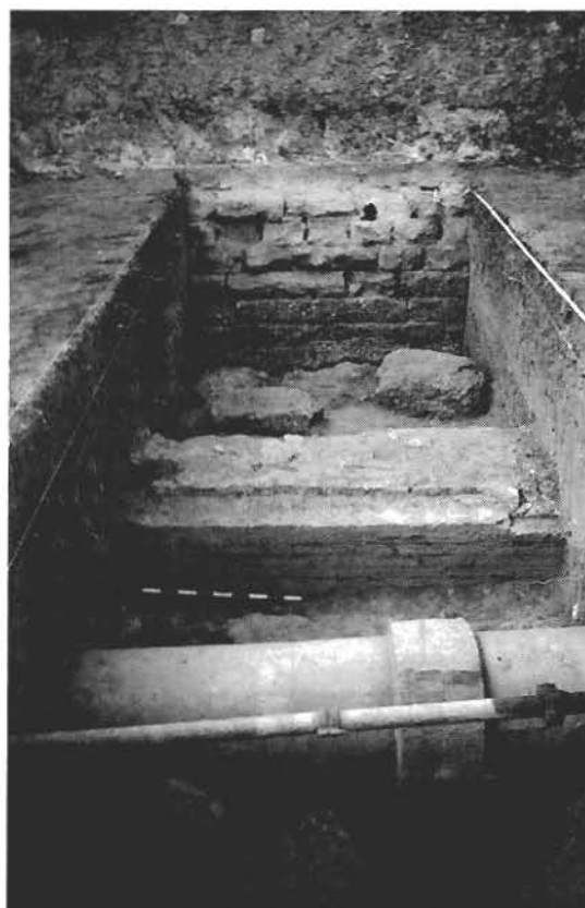
FOTO 2. Vista frontal del tramo de barbana estudiado en el corte 4 y su relación con el amurallamiento actual
