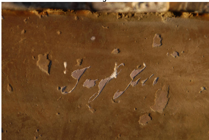
Firma en la bóveda de la Capilla Real.
