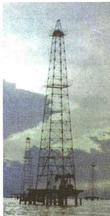
Torre de petróleo en el lago de Maracaibo.
