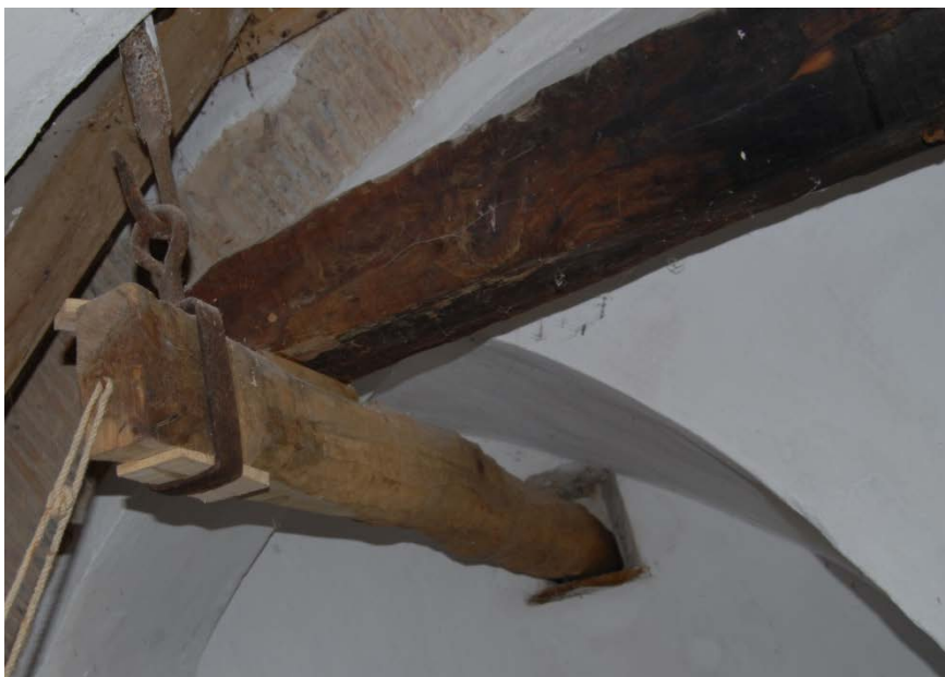
Figura 13. Fotografía de parte del sistema de alivio del molino de viento.
