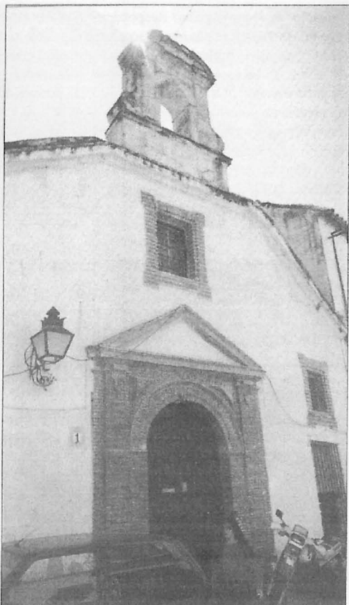
Fachada de la ermita de la Consolación. Albergó en los últimos años a los niños expósitos. Aun queda como muestra de su función el tornillo que da nombre a la calle aneja, donde se depositaban
