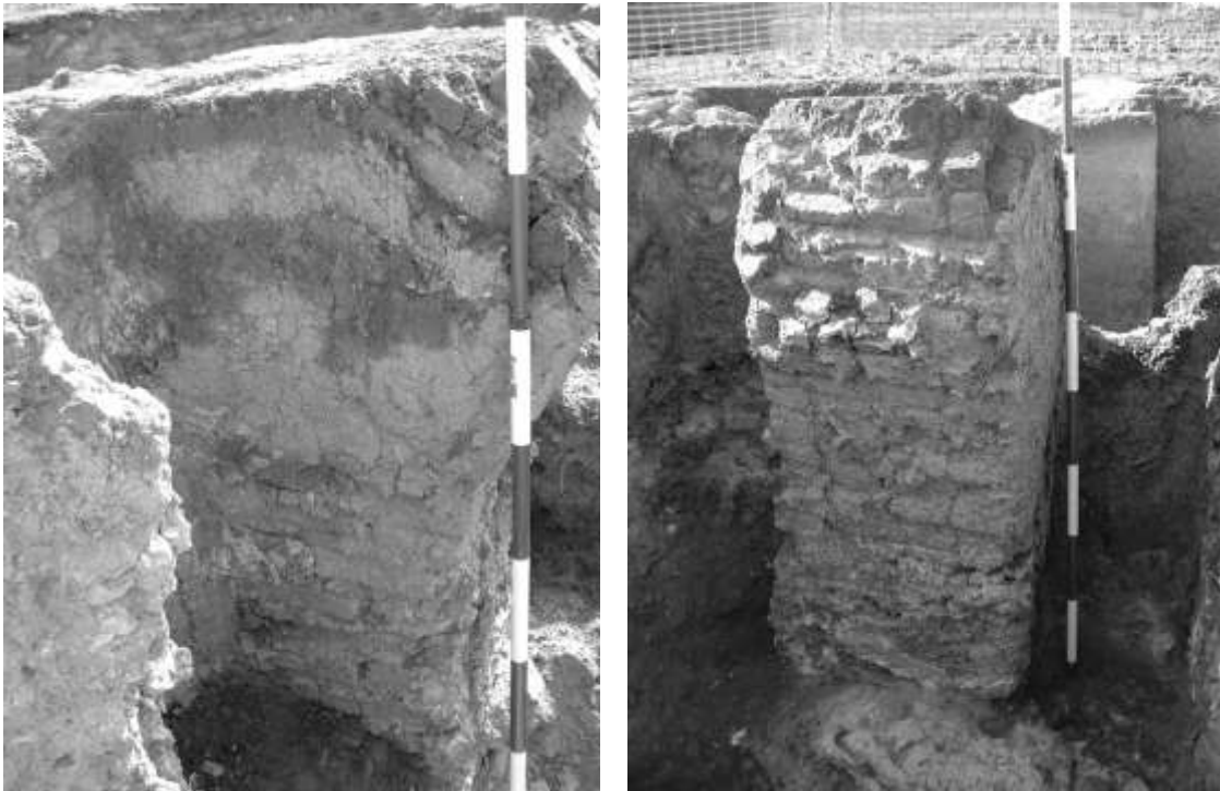
7.10.60. Detalle del arranque del arco y del pilar fabricados con ladrillos (MOLINA, 2004).
