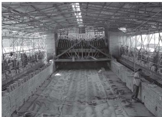
Fig. 1. Nave central de Abd al-Rahman I a la altura de cubiertas. Al fondo, bajo la armadura, el escudo del obispo Salizanes. Delante, extradós de las techumbres colocadas por Velázquez Bosco en 1919, tapadas durante las obras.
