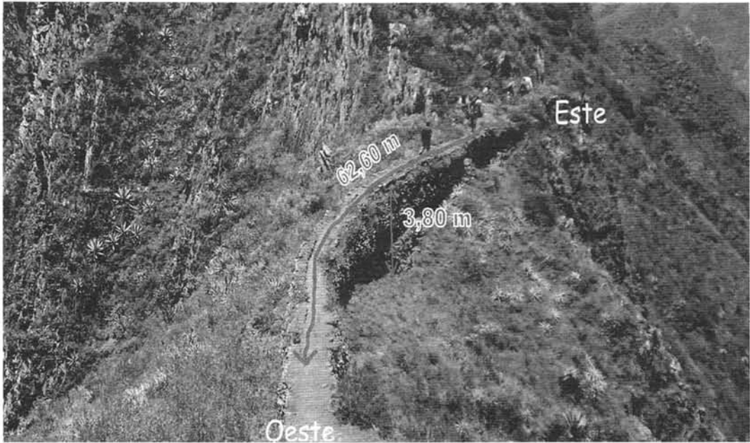
Figura 7. Longitud y altura máxima del muro en el tramo de canal estudiado.
