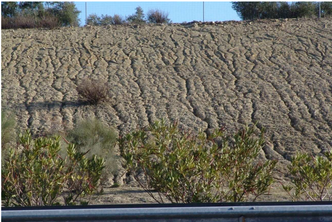
Figura VII 4. Talud en margas azules (Aguilar-Lucena).
