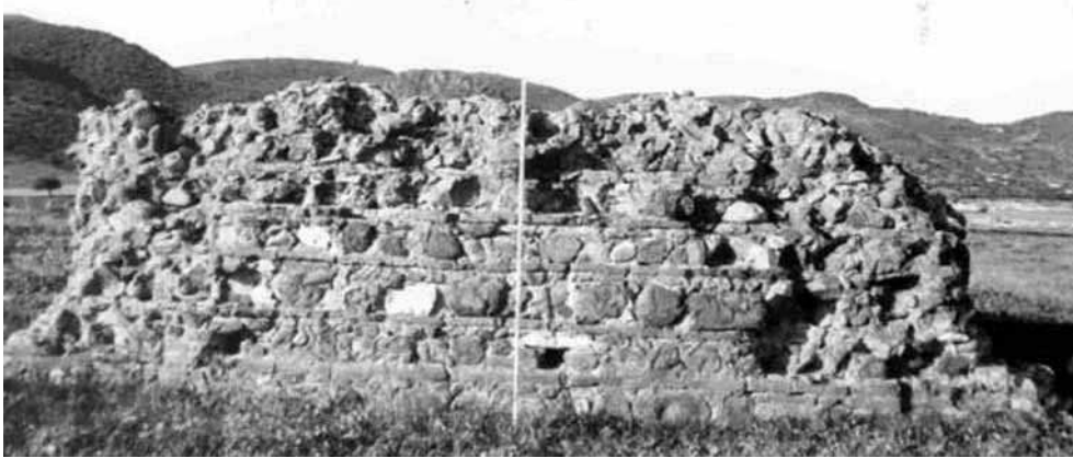
LÁMINA 4: Edificio religioso-funerario del centro metalúrgico de S. Jerónimo.
