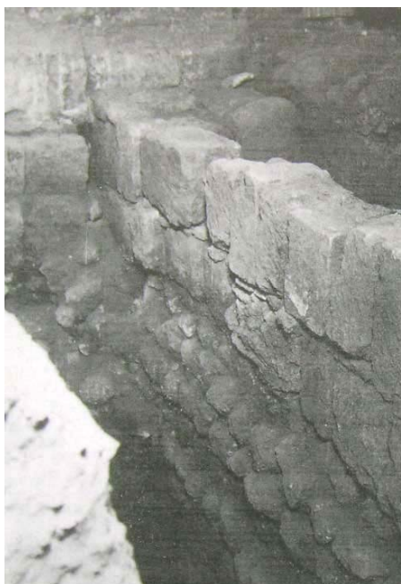
Fig. 156. Estructuras de sillería recuperadas al interior de la sala de oración (4ª y 5ª nave) (MARFIL, 2000a, 166, Foto 2).
