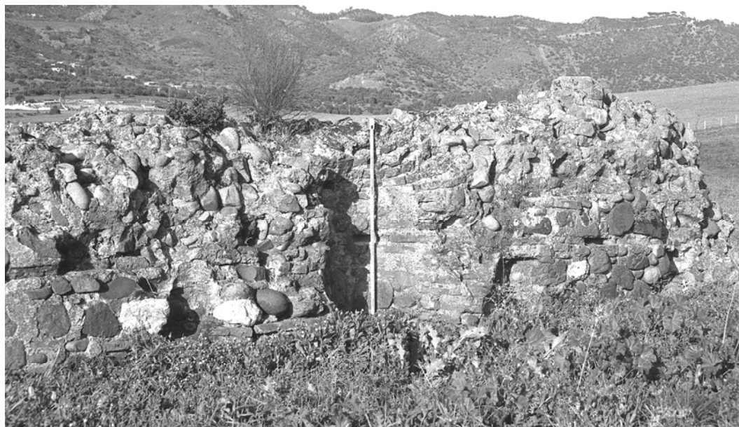
Fig. 163. Estructura de opus vittatum mixtum en las inmediaciones de Madinat al-Zahra (Foto: A. Ventura).
