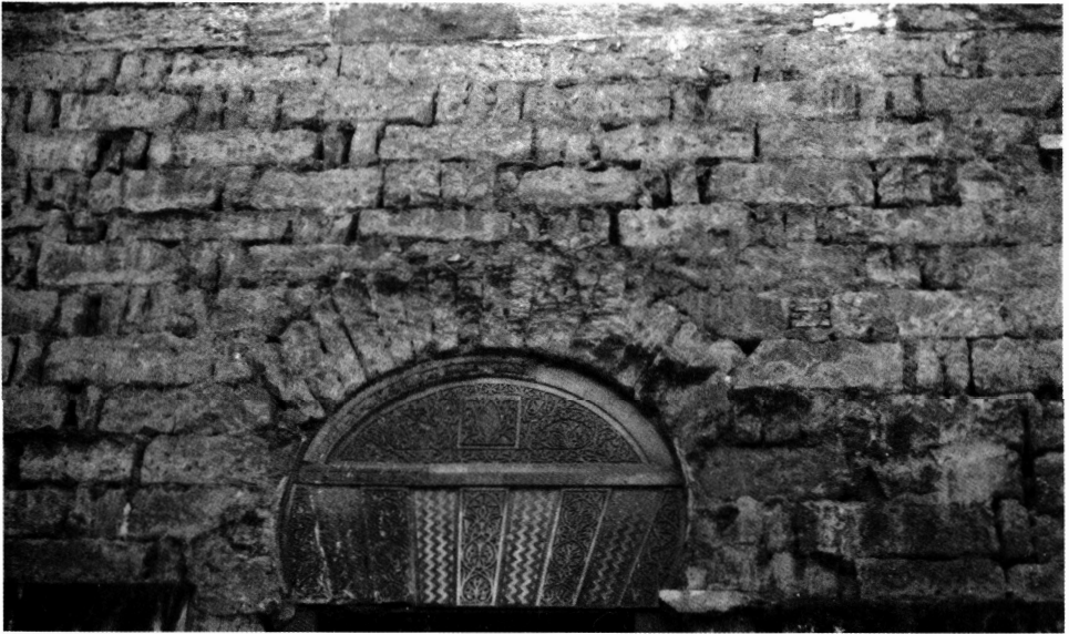
Lámina 9: Aparejo de la fachada oriental de la Mezquita Aljama, ampliada por Almanzor, previamente a la última restauración.
