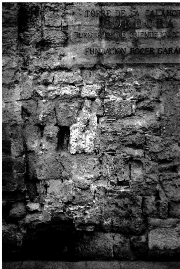
Lámina 6: Detalle de la jamba oriental original, parcialmente conservada y reparada con reformas cristianas, sobre la que apoya la importa biselada de mármol blanco (ver fig. 3).
