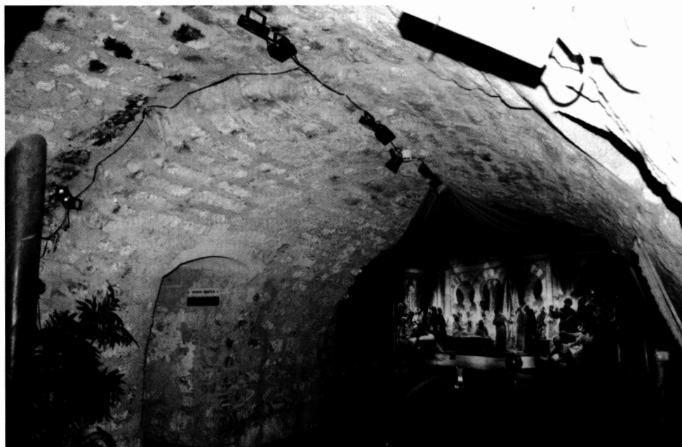
Lámina 7: Intradós de la bóveda conservada en el segundo piso interior de la torre.
