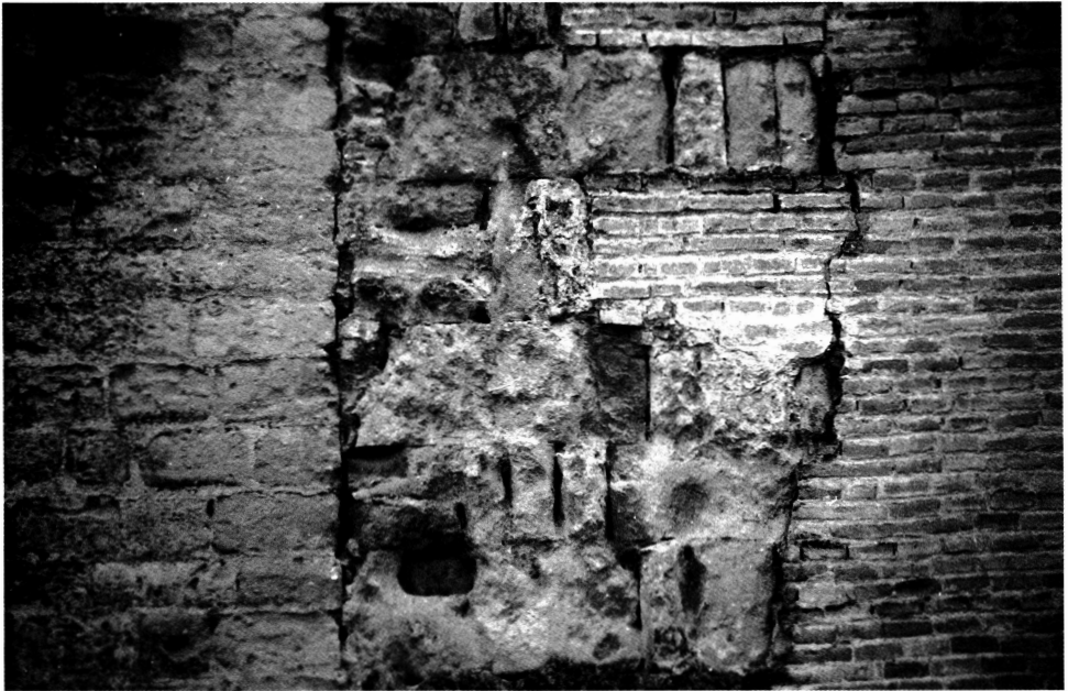
Lámina 8: Aparejo califal de la torre-puerta primitiva dispuesto sobre el trasdós del arco:
