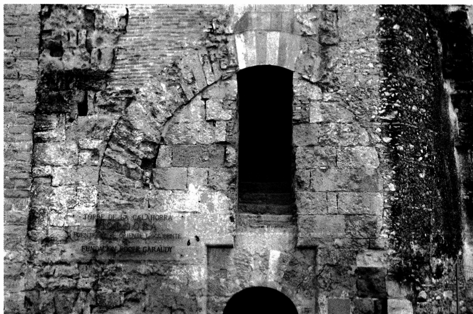
Lámina 4: Detalle del arco, cegado y reparado en época moderna con diversas fábricas.
