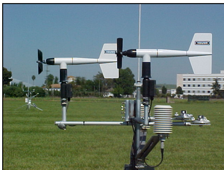
Figura 11. Instalación de sensores en paralelo
