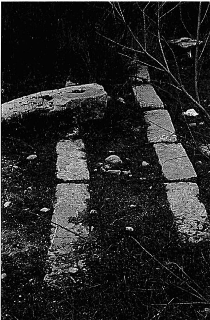
Lám. 6.- Tramo secundario o ramificación perpendicular al acueducto. con canalis de sillares.
