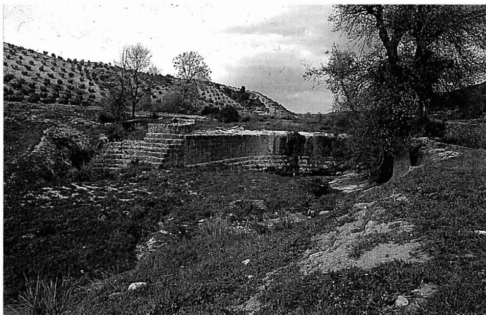
Lám. 2.- Vista general de la Presa de Barcinas desde el S/S-E.
