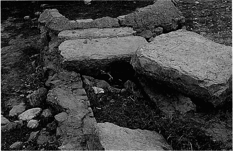
Lám. 5.- Tramo del acueducto donde apreciamos el canalis colmatado y la cubierta. Al fondo los restos del segundo spiramem .
