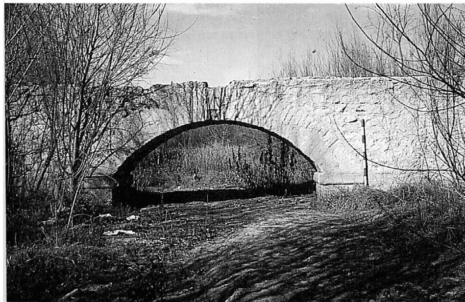
Lám. 4.- Substructio con arco central del acueducto en el Barranco de los Arcos.
