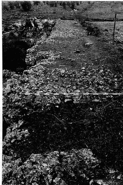
Lám. 2. Aliviadero del lado este.
