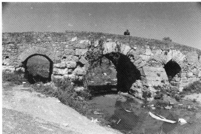
Lámina 4. a: Idem, detalle de los almohadillados y engatillado de las dovelas.
