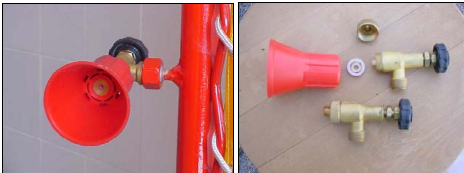
Figura 8.17.-Detalle de boquilla y de sus elementos.
