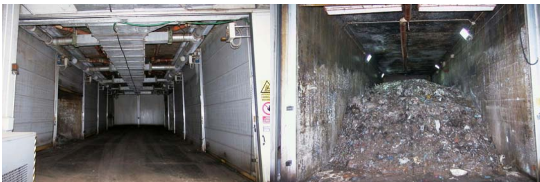
Figura 30. Vista general y de detalle de los túneles de estabilización.
