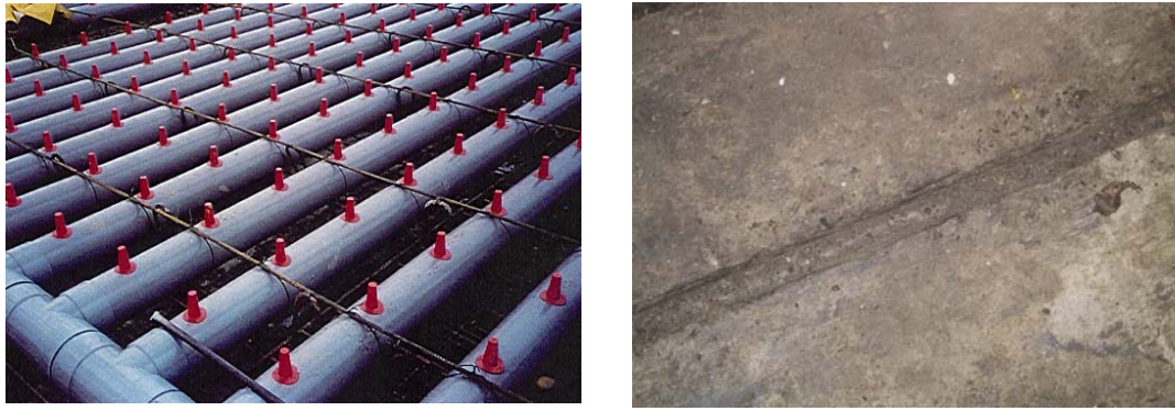
Figura 23. A la izquierda, suministro de aire en el suelo de un túnel en construcción (sin cubrir) y a la derecha, detalle de suelo perforado del túnel (ya cubierto).
