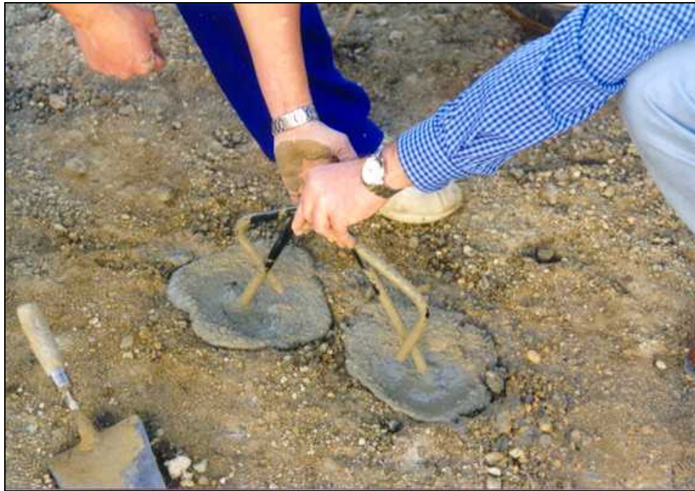
Fig. 27: Ejecución de un anclaje tipo 11.
