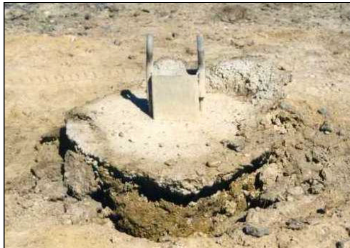
Fig. 94: Estado de un anclaje tipo 4 tras ser ensayado.
