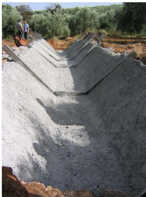
**Figura 2.9.** Hormigonado inicial según secciones maestras del diseño en Setenil.
