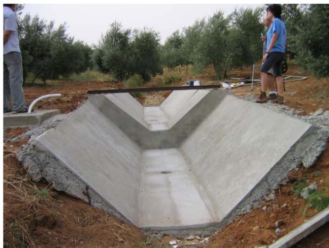
**Figura 2.11.** Resultado final del aforador con un soporte para el establecimiento de sensores y una plataforma (izquierda) para la colocación de una caseta. (Setenil)
