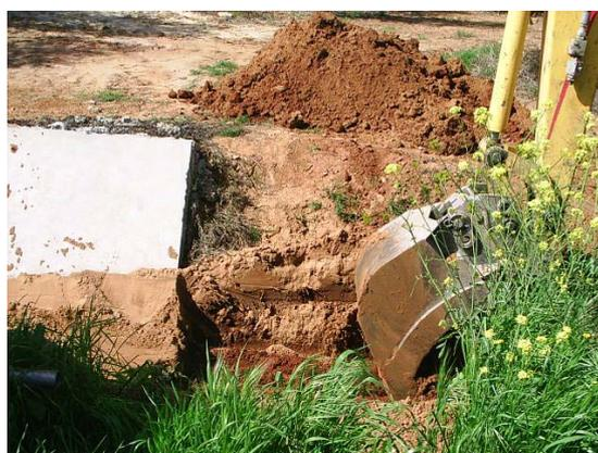
**Figura 2.29.** Retroexcavadora retirando sedimentos a la salida del canal tras las lluvias ocurridas en Setenil en marzo de 2006 (21 de marzo)
