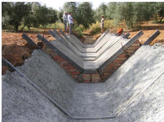
**Figura 2.10.** Establecimiento del desnivel y las cotas finales previstas en el diseño para el aforador (Setenil)
