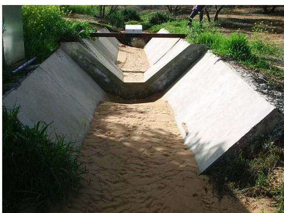
**Figura 2.28.** Estado del canal colmatado hasta la salida tras las lluvias ocurridas en Setenil en marzo de 2006 (21 de marzo)
