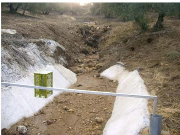
**Figura 2.39.** Canal y aforador colmatados por los sedimentos que arrastró la avenida del día 10 de octubre de 2005 en Puente Genil.
