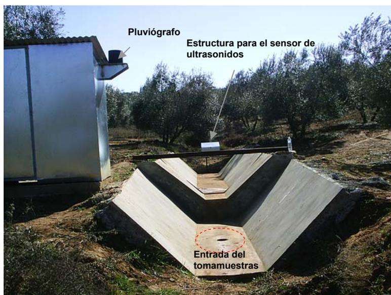
Figura 2.22. Vista general del aforador, la caseta y la estructura del sensor de nivel en Setenil
