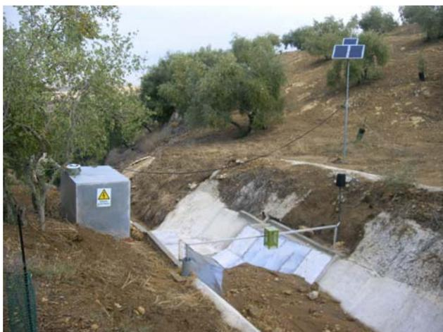
**Figura 2.26.** Instrumentalización de la salida de la cuenca de Puente Genill, con el canal y el aforador colmatado por las lluvias del 10 al 12 de octubre de 2005.
