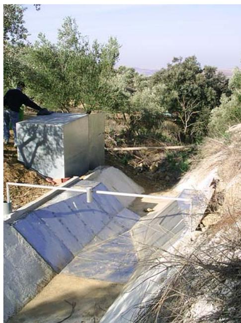
**Figura 2.20.** Imagen final de aforador, caseta y soporte para el medidor de nivel (Puente Genil).
