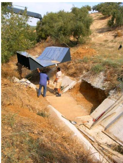
**Figura 2.19.** Grúa situando el aforador en la solera (Puente Genil).
