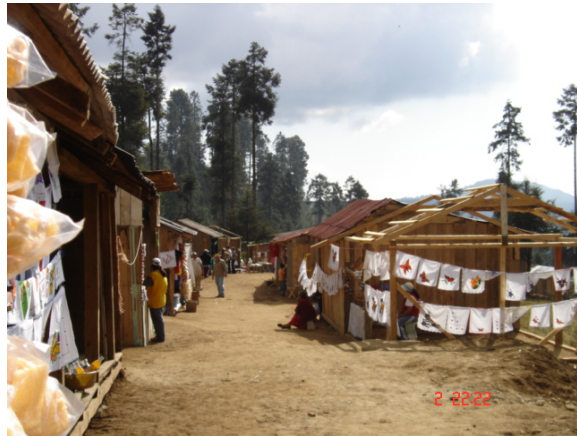
Foto No. VI.11: Las instalaciones provisionales del nuevo corredor.
