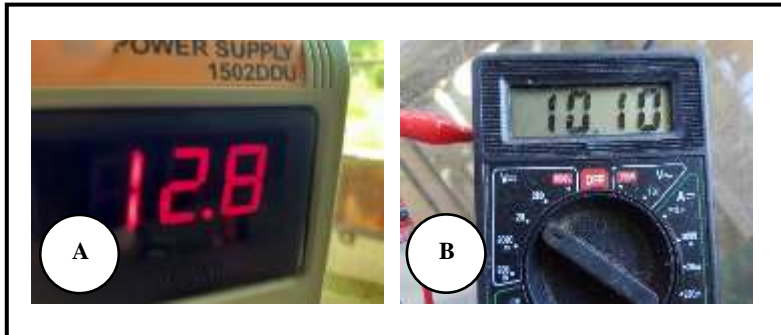
Pengukuran tegangan pada proteksi katodik (a) pada rangkaian menggunakan rectifier (b) pada rangkaian menggunakan baterai
