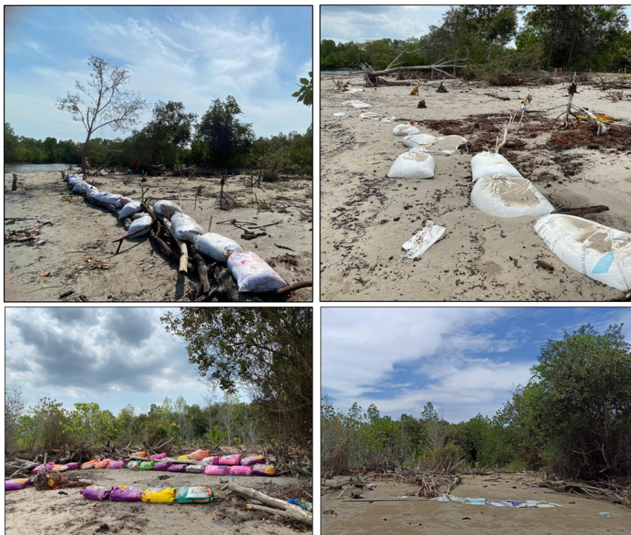
Gambar 4. Sand bag penahan ombak dan sedimen pantai; sisi kiri saat instalasi; sisi kanan 1 bulan setelah instalasi
