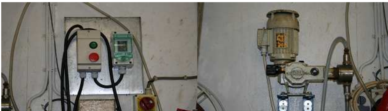
Figur 9. Til venstre ses doseringsmekanismen og til højre doseringspumpen.
