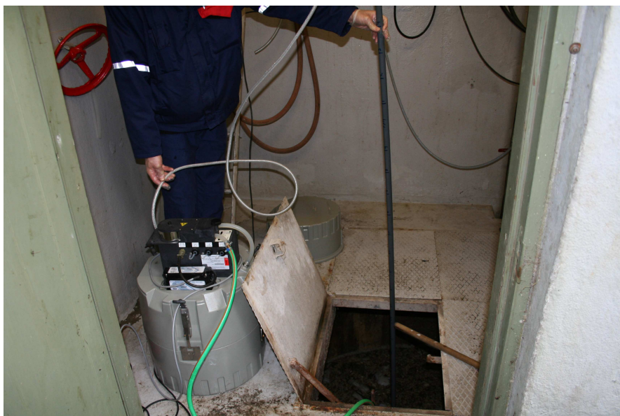
Figur 13. Udtagning af prøver ved hjælp af selvkonstrueret rør til kontrol af fuld opblanding.
