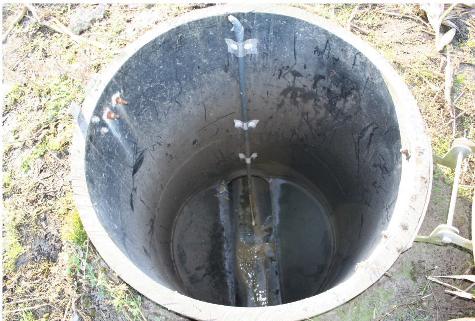
Figur 12. Slangen til autosampleren er monteret i oppumpningsbrønden således, at der er fri passage for større objekter.
