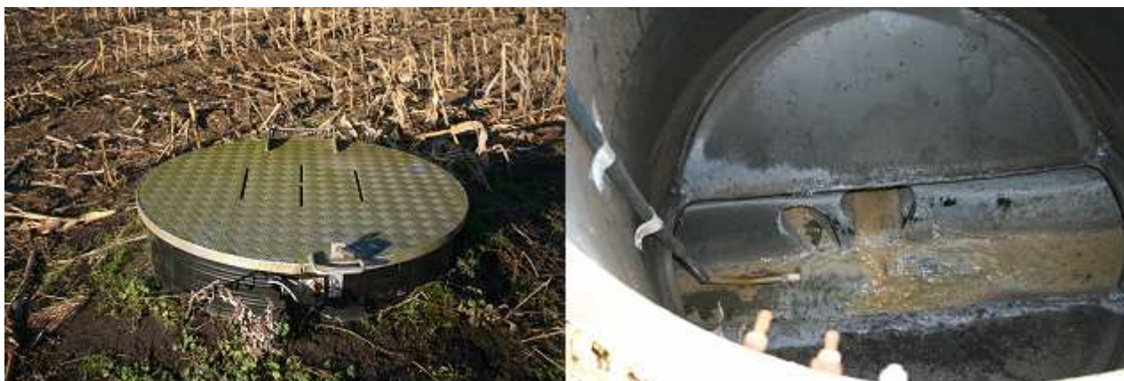
Figur 7. Venstre billede er det galvaniserede låg, med udluftning. Højre billede er bunden af brønden med de to tilløb fra Håls og Fjellerad.
