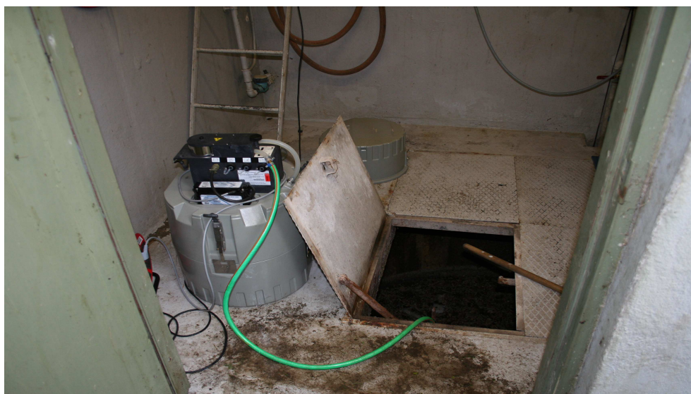
Figur 10. Autosamler i pumpestationen.
