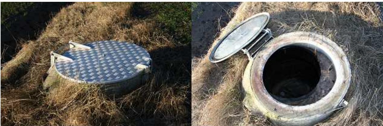
Figur 8. Venstre side viser det lufttætte dæksel og højre side viser brønden af PE med betonkrave til dæksel.
