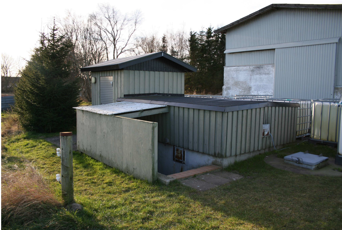
Figur 5. Pumpestationen ved Dollerup, med indgang til teknikrum i venstre side og nedgang til pumperum og pumpesump midtfor.
