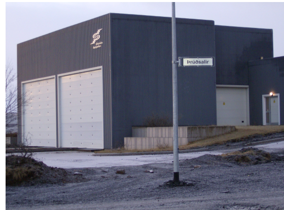
Figur 1.3: Transformerstation A7 beliggende i udkanten af Reykjavik.
