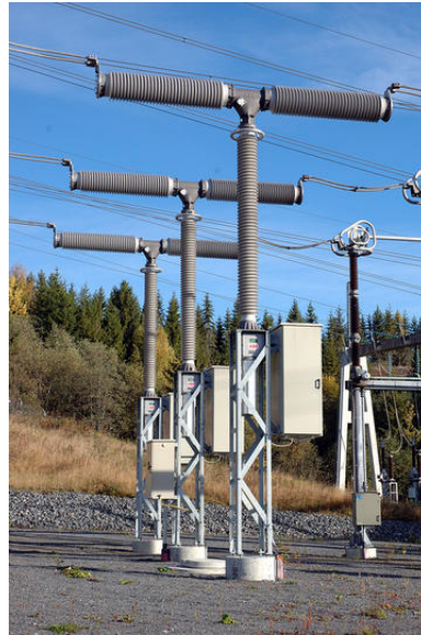
Figur 2.3: Eksempel på afbrydere mellem højspændingslinier [ABB(26-10-2007)].
