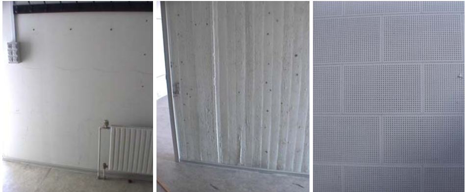
Figur 7.3: Til venstre ses et eksempel på en gipsvæg, i midten en betolvæg og til højre en væg med lydisolerende materiale.
