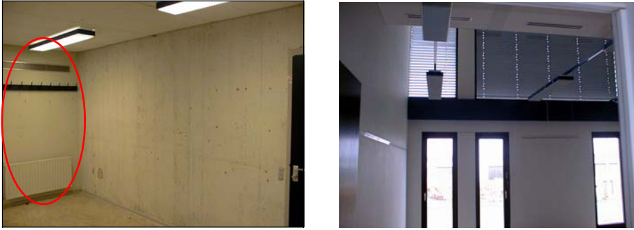
Figur 7.5: Billedet til venstre viser rum 5.17, hvor en radiator, en ventilationskanal og en knagerække på sydvæggen kan ses. Billedet til højre viser rum 5.20, hvor vinduespartiet i sydvæggen kan ses samt en blå plade foran radiator.
