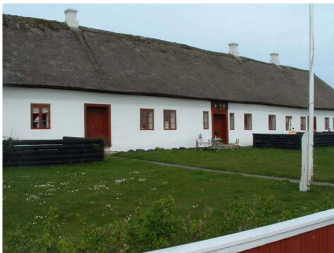
Figur 8-14 Eksempel på et af de ældre huse, der skaber det særlige bymiljø i Blokhusr
