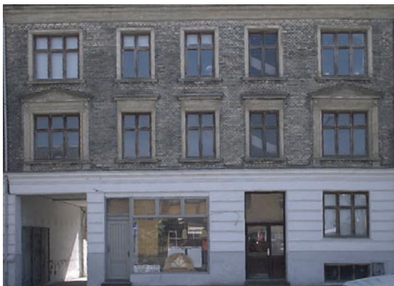
Figur 7.20: Facadebilledet korrigeret 0,25 m i begge sider og front.
