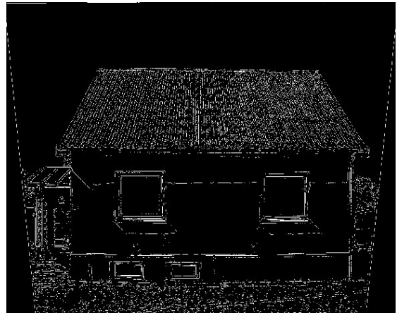
Figur 7: Hadsundvej 170. Kantpixler detekteret med LoG filter. Grænseværdien er sat automatisk.
