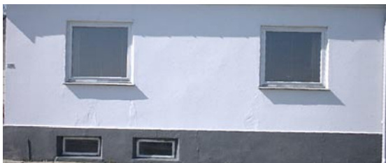
Figur 7.12: Et af de oprettede og udklippede billeder fra facaden på Hadsundvej 176.
