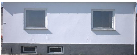
Figur 7.16: Facadebilledet korrigeret 0,25 m i begge sider og front.
