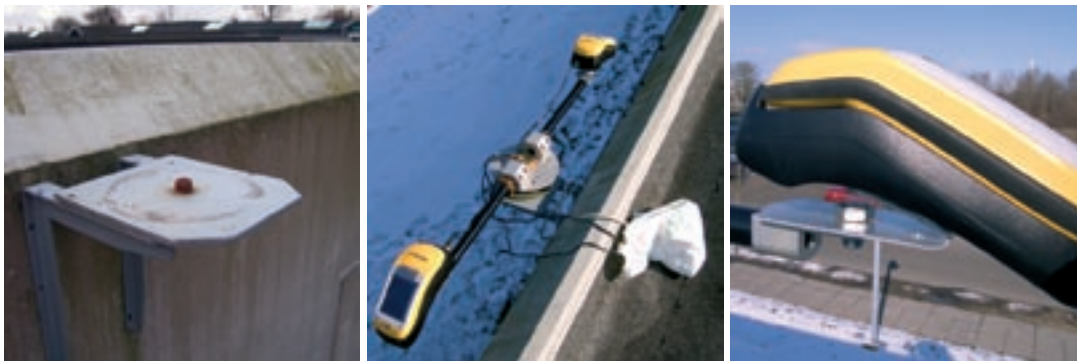
Figur 4.1: Billede A: Fikspunkt ved Fib. 11. Billede B og C: Montering af GeoXT-modtagere.
