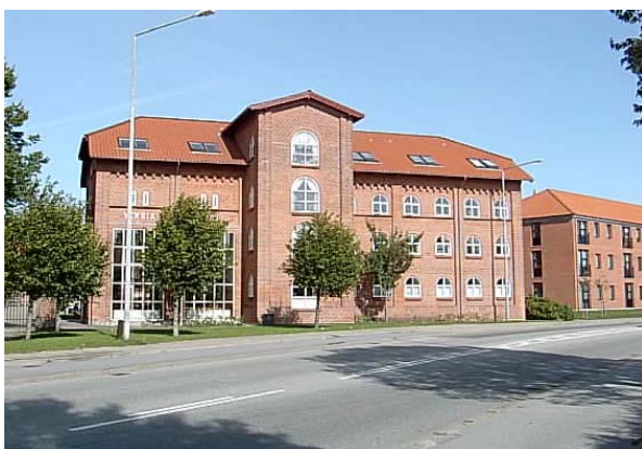
Bryggeriet efter omdannelsen til ældreboliger
