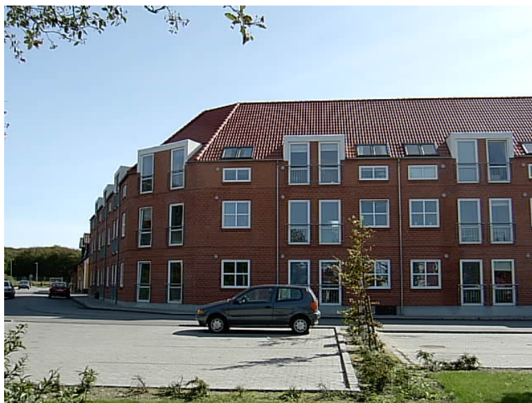
Det nyopførte almennyttige boligbyggeri på Plantagevej 6-8
