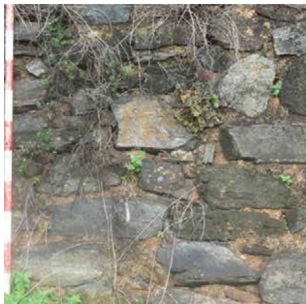
Figura 11: Detalle de la fábrica de mampostería sin enfoscar. Subtipo 5-2.
