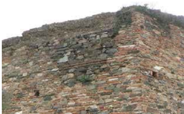
Figura 12: Detalle de fábrica de mampostería con alineamiento de ladrillos. Aparejo Toledano. LD/7-2.
