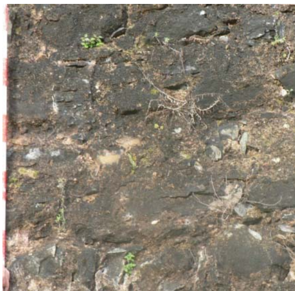
Figura 14: Detalle de la mampostía Tipo 3, con un enfoscado de recubrimiento total.
