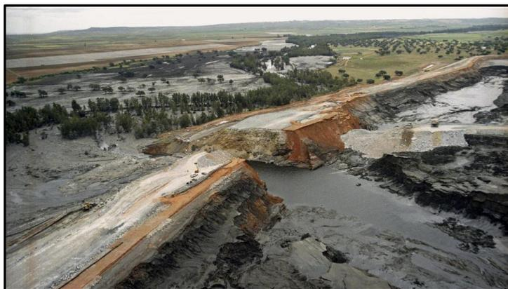
**Figura 16.** Rotura del muro de contención de la balsa minera de Aznalcóllar.
