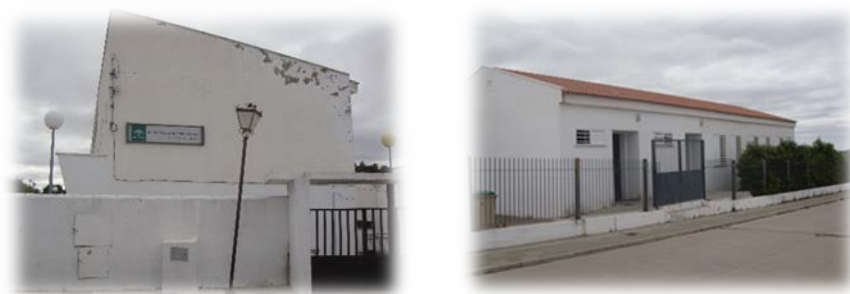
Figura 23.1: fotografías fachada CEIP
