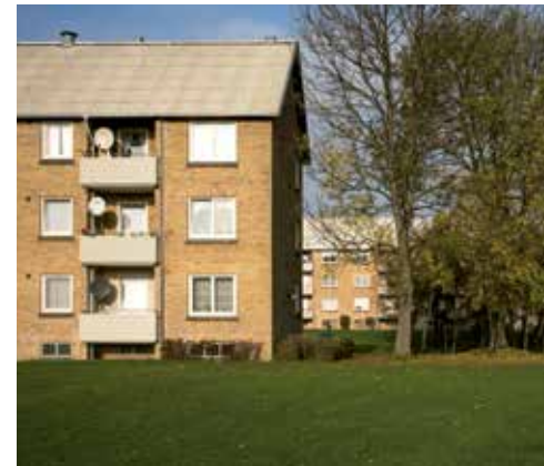
Facade (kilde: Energimærkingen fra fsb).
