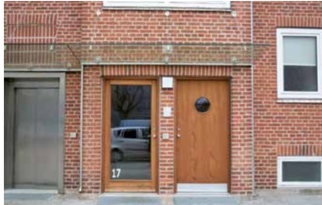
Der er monteret en let glasafdækning over de eksisterende indgangsdøre, og vinduerne over elevatorindgangen er blevet udmuret i lodrette teglsten under de bevarede murstik.
