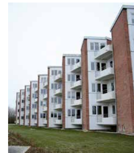
De arkitektoniske kvaliteter i facaderne er i høj grad bevaret, som det ses ved de for perioden karakteristiske, let drejede altaner mod vest.
