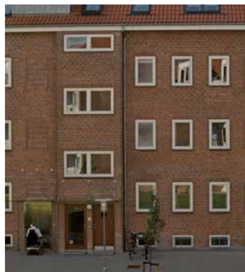
Eksempel på, at elevatoren er placeret inde i bygningen ved siden af trappeforbindelsen. Man har her inddraget noget areal i lejlighederne og derved sikret, at der er adgang til alle lejligheder for alle. Elevatorens vertikale motiv er markeret i facaden og understreger derved facadens eksisterende rytme. Eksemplet er fra Sprotoften i Nyborg, opført i 1952.
