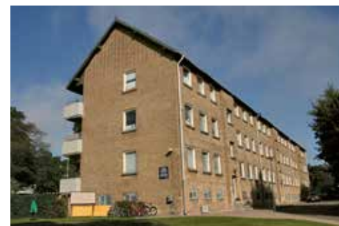
Gavl/facade (kilde: Københavns Museum).
