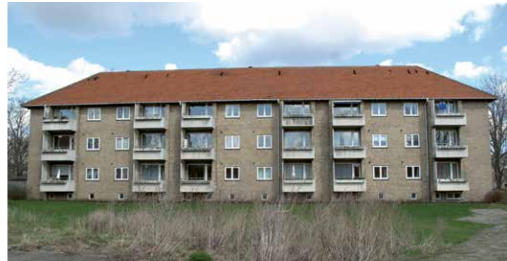
Fortunbyen før renovering
