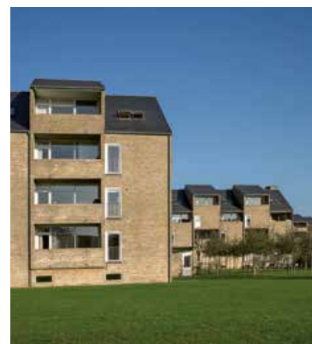
Alléhusene, Gentofte, arkitekt Arne Jacobsen. Et eksempel på et parklignende underum med enkeltstående træer, hvor plænen går helt hen til bygningen, og kontakten mellem inde og ude sker via altankarnappen.
