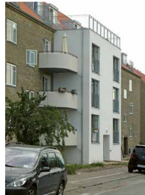
Tilbygningen har ved lejlighedssammenlægningen gjort det muligt at skabe nogle mindre boliger velegnet til voksne, der bor alene, eller par uden børn.
