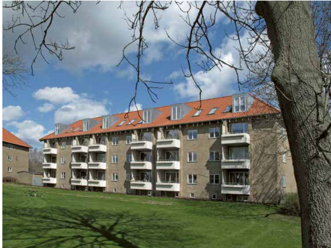
De tidstypiske facader med gule mursten og hvide altaner står uberørte efter renoveringen, hvor nye tagboliger blev etableret.
