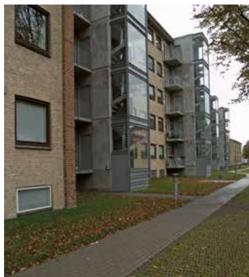
Eksempel på placering af et elevator-/trappetårn uden på facaden, der understreger de vertikale træk i facaden og samtidig muliggør adgang til alle lejligheder i opgangen for både beboere og besøgende, uafhængigt af funktionsevne. Eksemplet er fra Vanggården i Aalborg, opført 1941-1943
