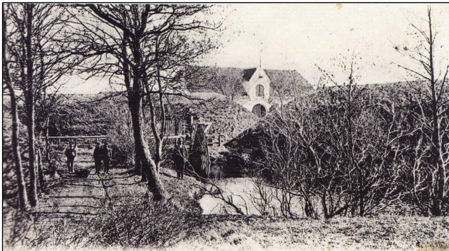
Fig. 18. Hals Skanse, sidste del af 1800-tallet. Skansen er fotograferet fra ravelinporten efter nedlæggelsen af skansen som fæstning 1848. Endnu er hovedbroen ikke erstattet af dæmning, men tunnelen gennem nordvolden er væk. Volden er dog forsynet med port, og hvor broen lander op mod volden ses de karakteristiske spærringer i brosiderne, hvor disse støder op mod volden. Billedet er formodentligt det ældste, eksisterende fotografi af Hals Skanse. 1099
