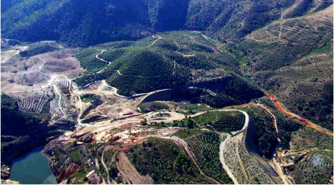
Figura IV.1.42. Degradación de la riberia del Villar por los vertidos de la mina Tinto Santa Rosa (obsérvese el cambio de color del río en la parte derecha de la fotografía)
