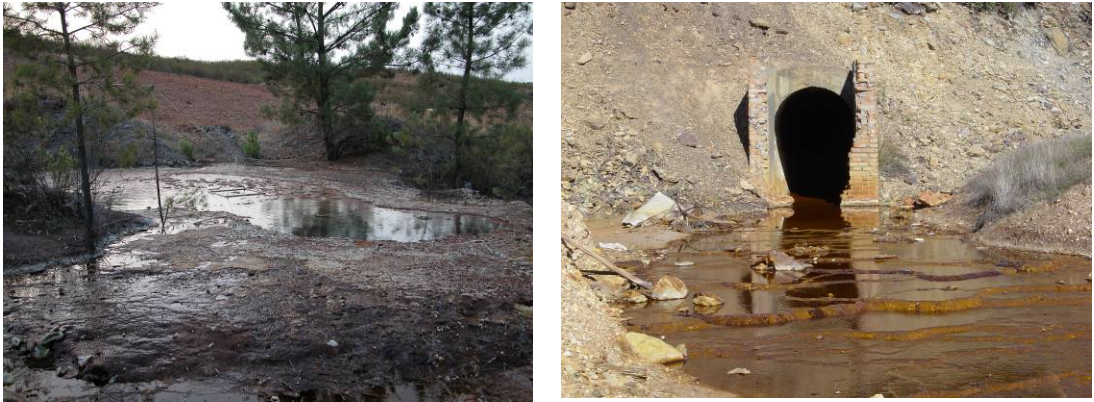
Figura IV.4.19. Pozo y túnel por donde manan los lixiviados de la mina Cueva de la Mora
