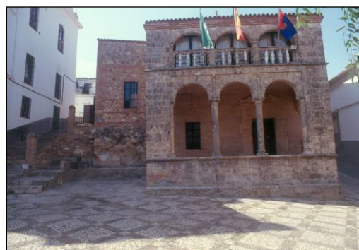
Figura 5. Los travertinos han sido aprovechados por la población de Zufre, no sólo como lugar estratégico para su ubicación, sino también como material de construcción. En la foto, el Ayuntamiento del pueblo, construido con este material.
