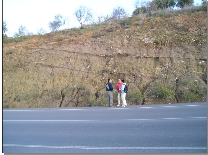
Figura 3. Basaltos intruidos en capas vulcanosedimentarias (sills), afectados por una pequeña falla (P3).
