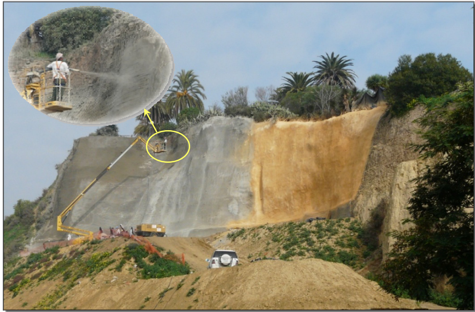
Figura 5. Panorámica de las obras de estabilización del talud formado por la Unidad Arenas Huelva-Bonares en la calle Aragón de la ciudad de Huelva.
