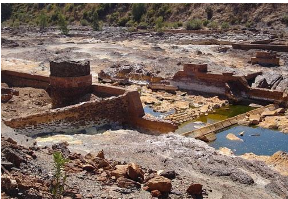
Imagen 3.32 Restos de puente en el Tinto. José Luis Gómez Díaz.
