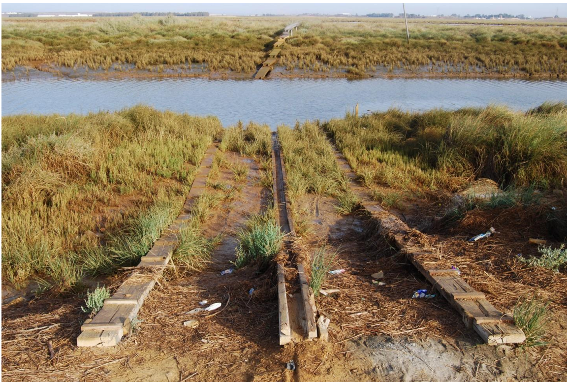
Imagen 4.2.23 Estructura de varadero en la orilla. Muelle de la Ribera. Moguer.
