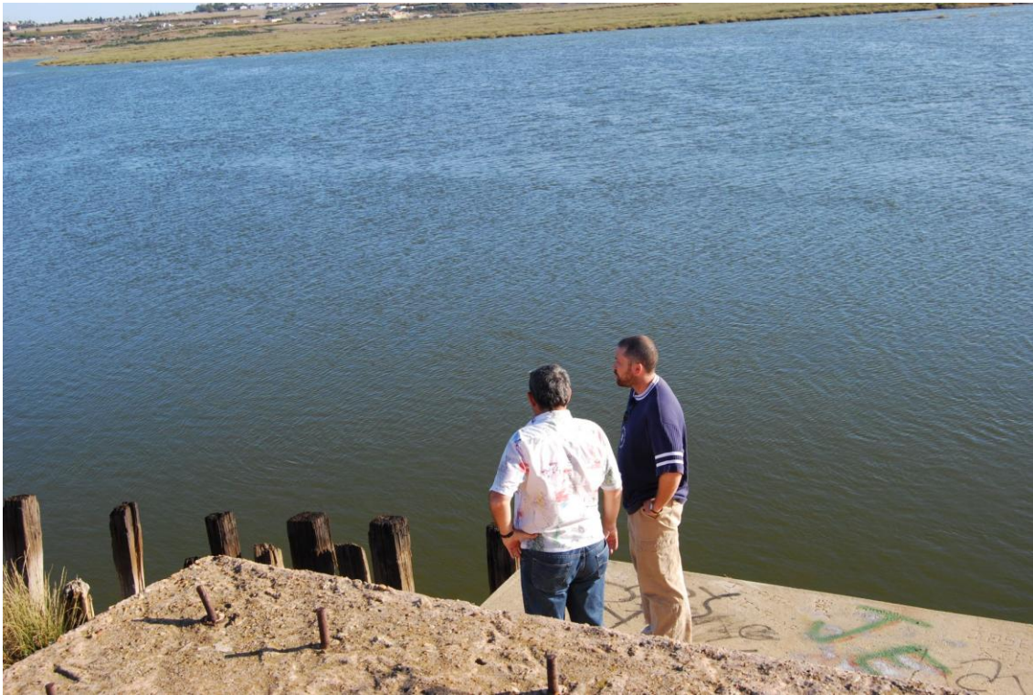
Imagen 4.3.13 Plataforma de hormigón junto a los palos del antiguo muelle. Autor.
