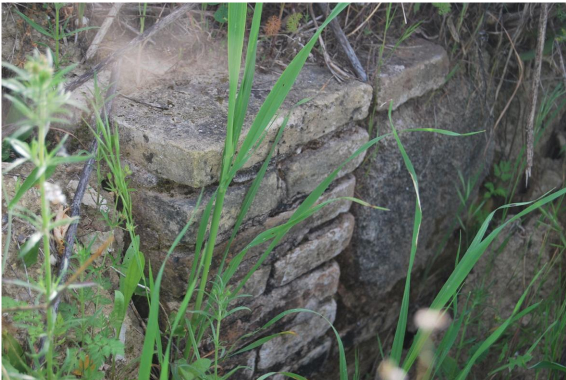
Imagen 4.4.5 Sillar de ladrillos y parte de muro.
