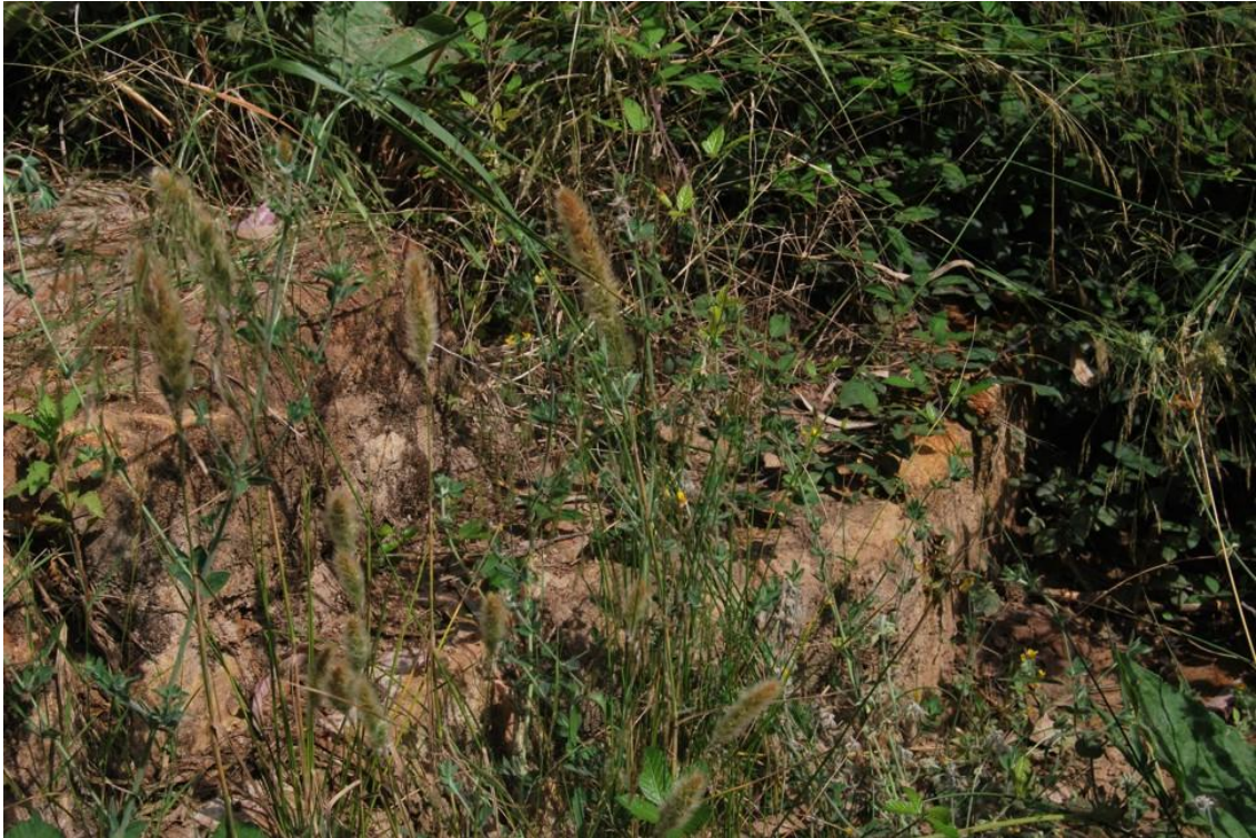
Imagen 4.5.15 Escalones de la escalinata en la actualidad, que se vuelven a cubrir por la vegetación. Autor.
