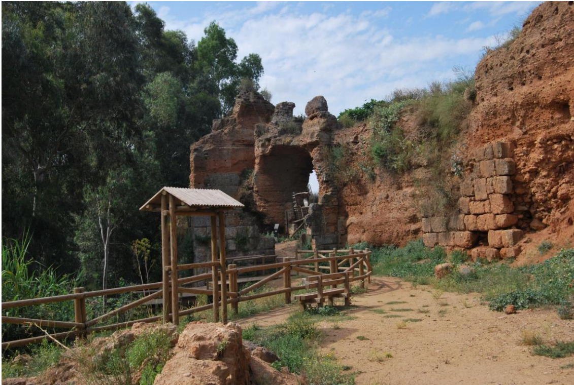
Imagen 4.5.14 Puerta del Embarcadero en su estado actual. Vista desde el exterior. Autor.
