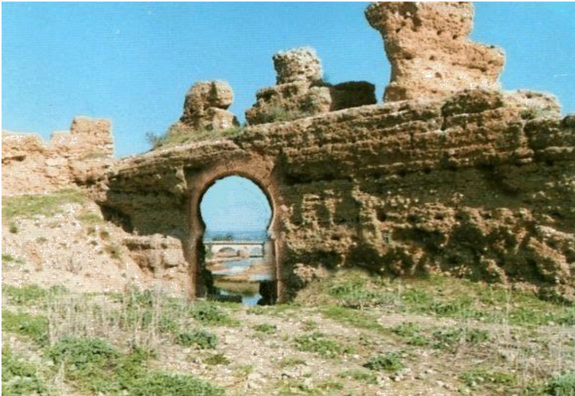
Imagen 4.5.13 Puerta del Embarcadero. Vista desde el interior. Imagen idealizada con el puente al fondo. Ayuntamiento de Niebla.
