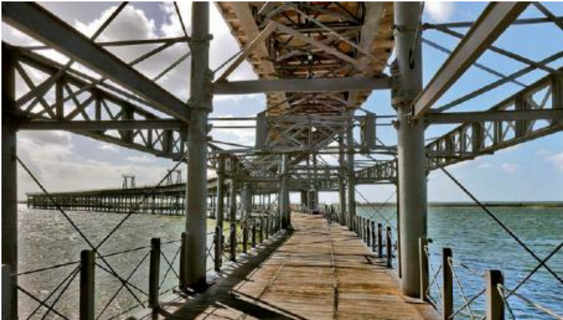
Imagen 4.3.6 Muelle de la Minas de Río tinto en el río Odiel. Huelva. Autor.
