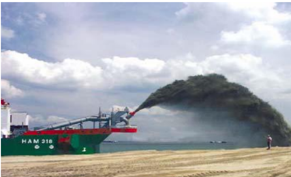
Imagen 5.34 Dragas de succión vertiendo el material mediante impulsión con el sistema “rainbow”.
