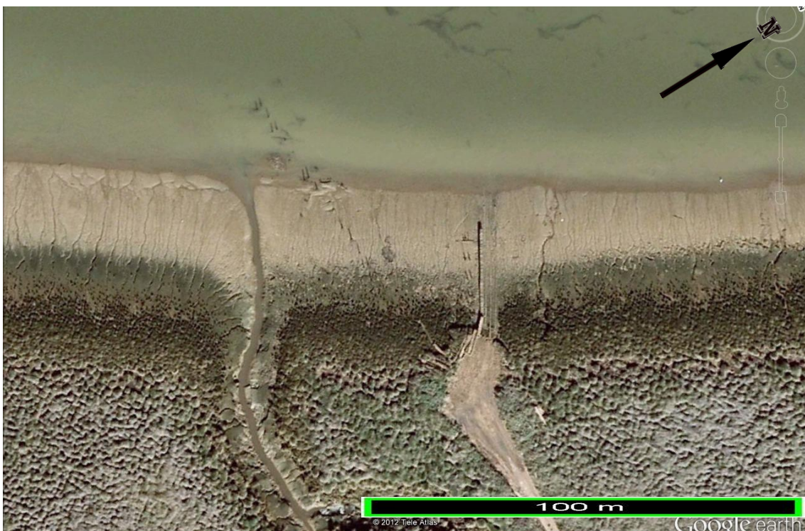
Imagen 4.2.30 Vista aérea del muelle de Santa. Detalle donde se observa los restos de pilotes en dirección oeste.
