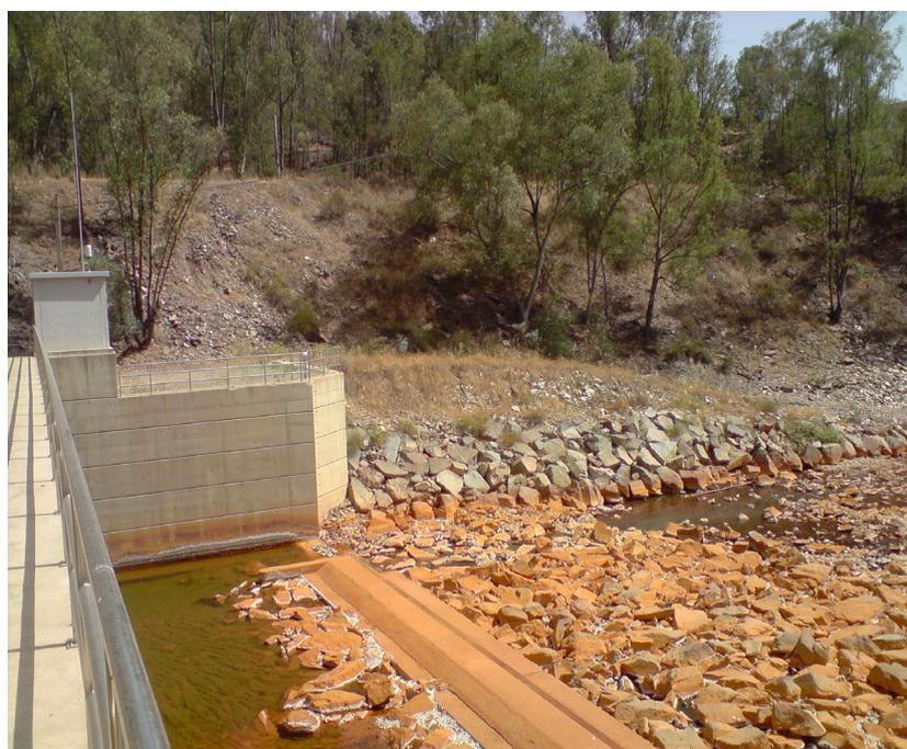
**Figura II.6.** Detalle de la nueva estación de aforo de la red SAIH del río Odiel en Sotiel, se puede ver el canal de estiaje.
