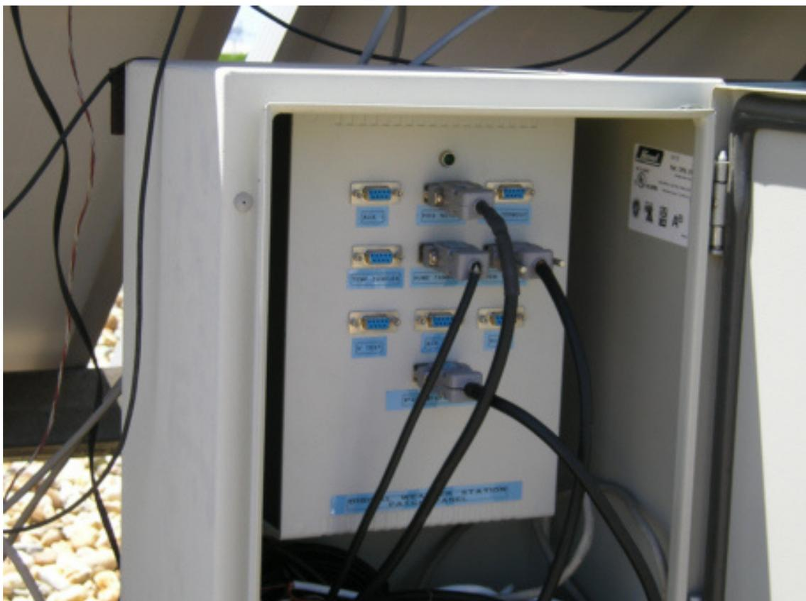
Fig. 6.5. Módulo exterior de conexiones
