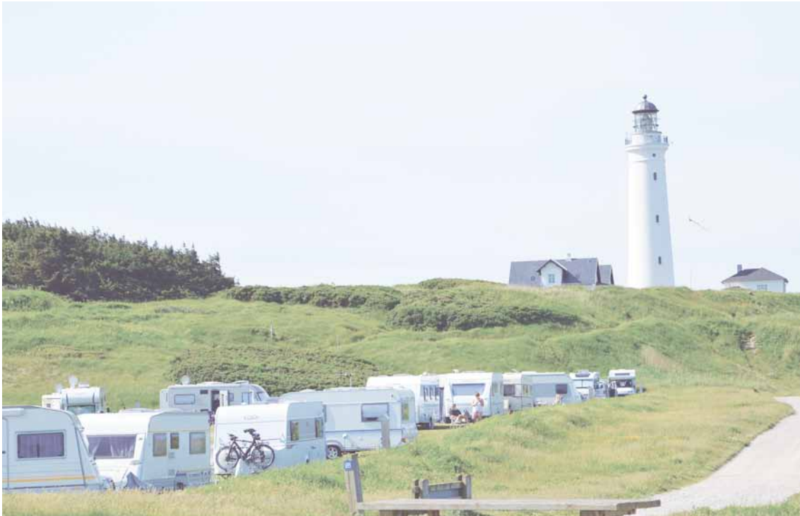
III. 55 Her ses tydeligt hvordan fyret står som en vogter over pladsen. Den landskabelige opbygning hertil og beplantning definerer pladsens bagkant men står også som et landskabeligt uudnyttet potentiale. Med et sådan landskab som bagtæppe er naturen allestedsnærværende på pladsen, og man kan virkelig mærke naturen på pladsen.
