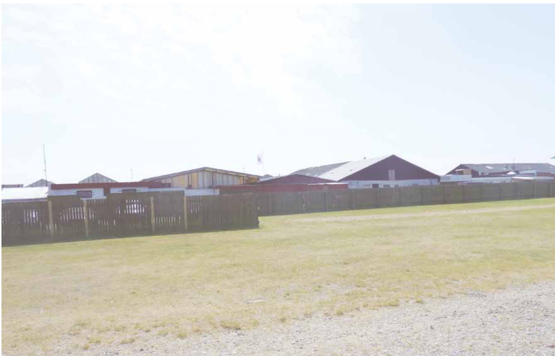
III. 37_Som billedet viser har campingpladsen en meget klar bagside, som ovenikøbet vender ud imod bagsiden på det nærliggende bycenter. Der er stor interesse i at få afskærmet dette da bycenterets diskoteket har skabt gener for nogle af pladsens gæster.
