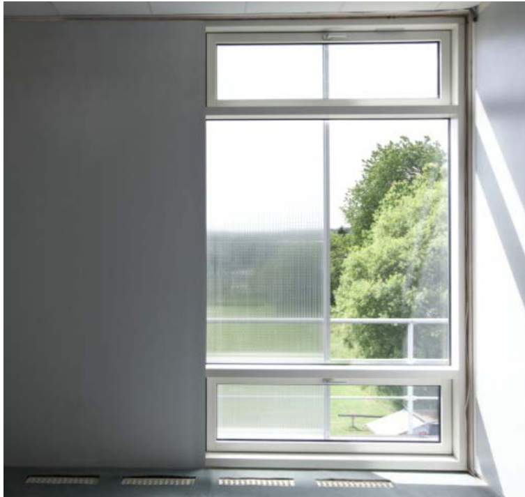
Figur 12. Energy Frames element, der både varmeisolerer og tillader dagslyset at passere.
