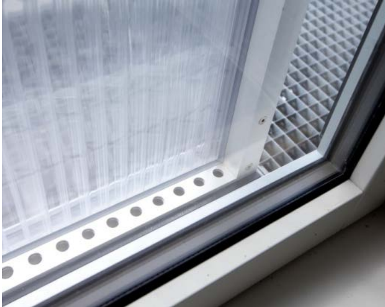
Figur 14. Energy Frames ventilationselementet med forskydelige hulprofiler indbygget foroven og forneden, således at åbningerne kan reguleres.
