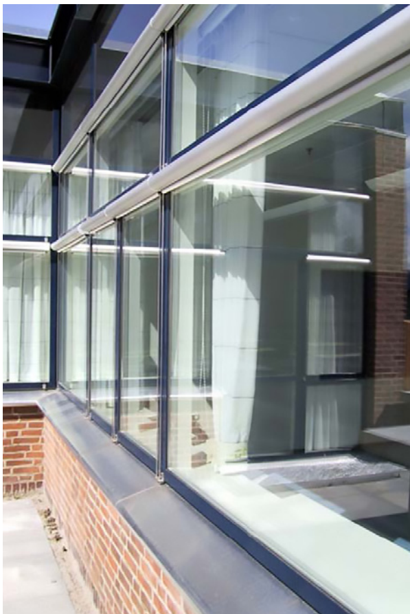
Figur 20. Eksempel på opdeling af facaden i et udsigtsvindue og et dagslysvindue.
